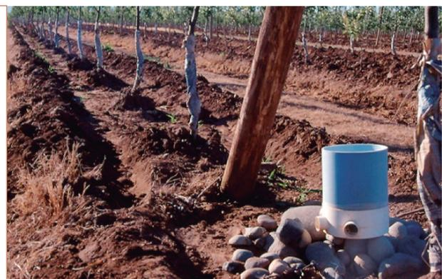
**Fotografía 2.5.** Vista de un sistema de aducción de baja presión o californiano.
