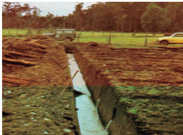
**Fotografía 3.5.** Drenes topo descargando a colector.
