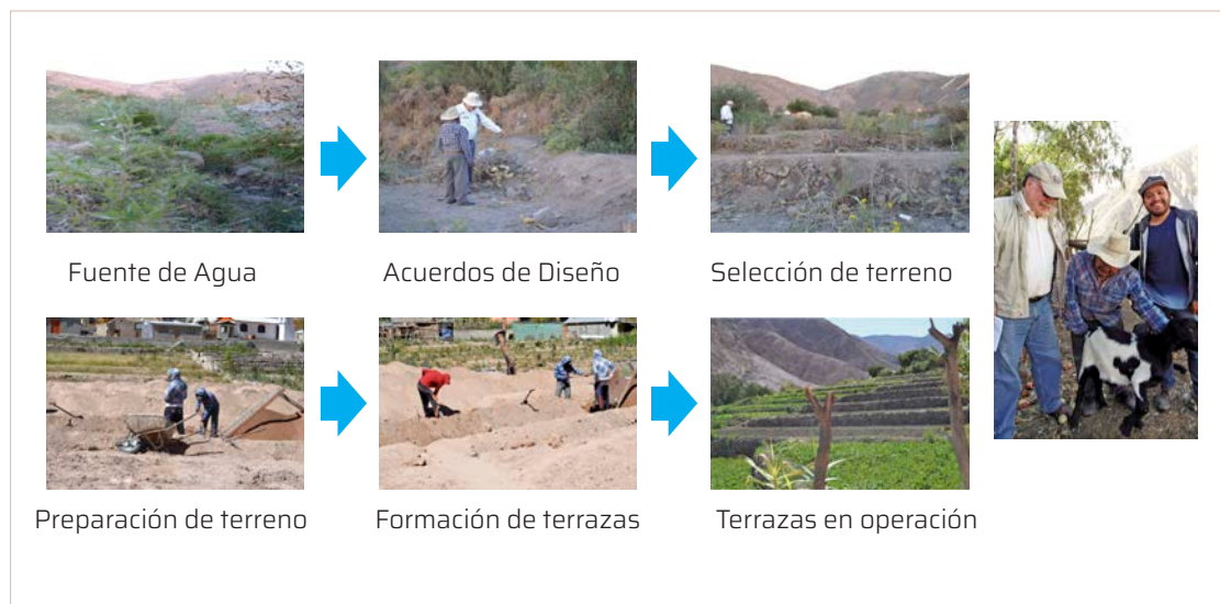
■ Figura 34. Secuencia de construcción de andenes en Camiña.
