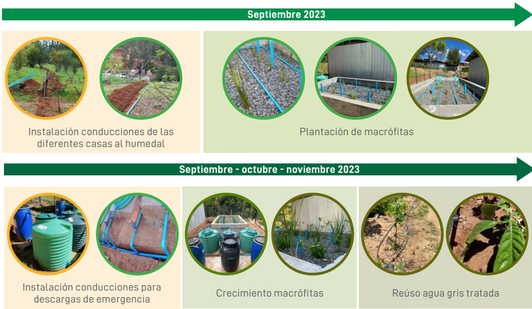
Figura 11. Línea de tiempo de la construcción (junio – noviembre 2023) del FVSS para la recuperación y tratamiento de las aguas grises de 3 viviendas del APR Deuca – El Manzano.
